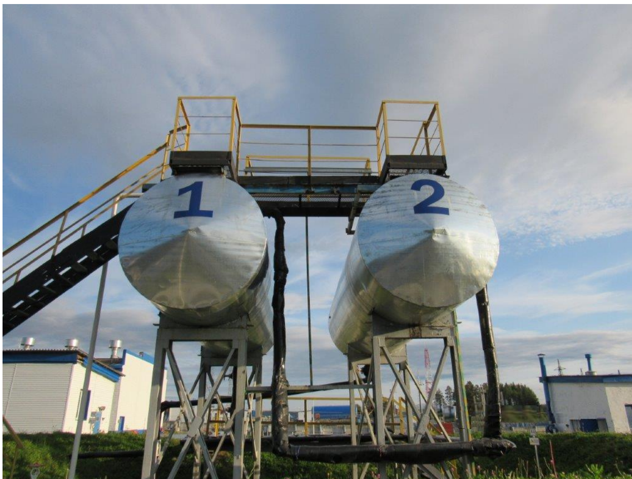
Рисунок 1 – Общий вид резервуаров РГС-20
