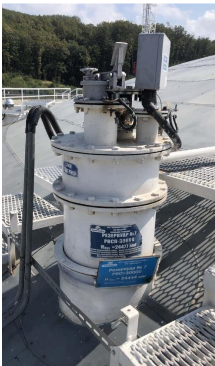
Рисунок 3 – Общий вид резервуаров РВС-30000
