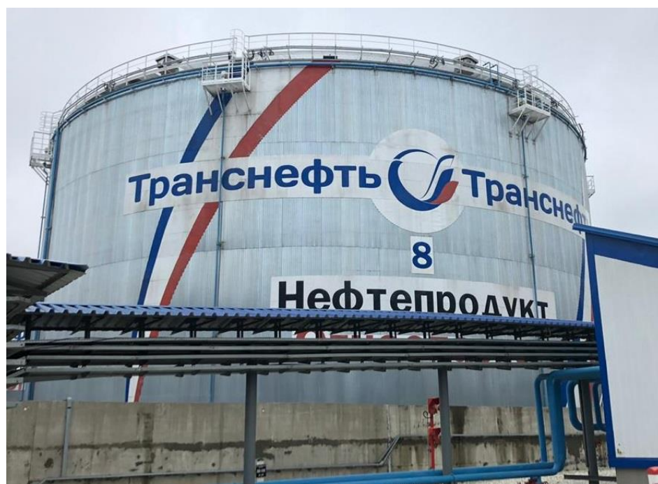
Рисунок 2 – Общий вид резервуаров РВСт-30000
