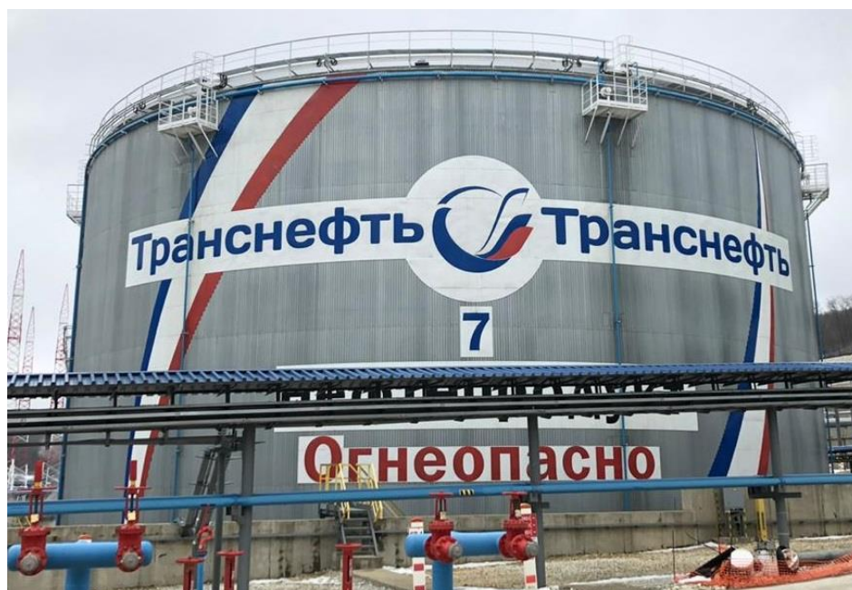
Рисунок 1 – Общий вид резервуаров РВСт-30000
