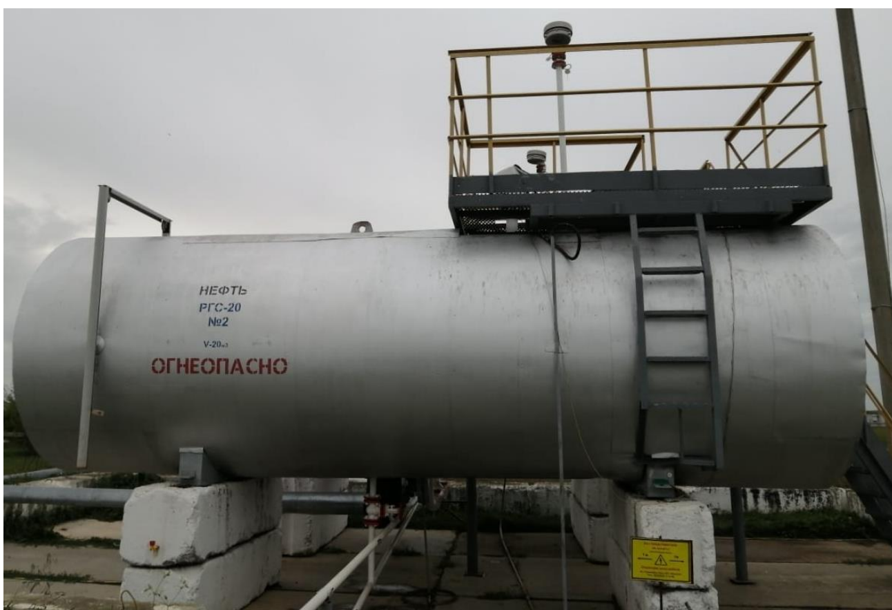
Рисунок 2 – Общий вид резервуара РГС-20 с заводским номером 2
