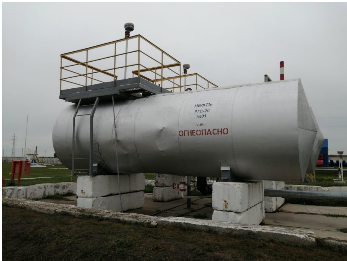
Рисунок 1 – Общий вид резервуара РГС-20 с заводским номером 1
