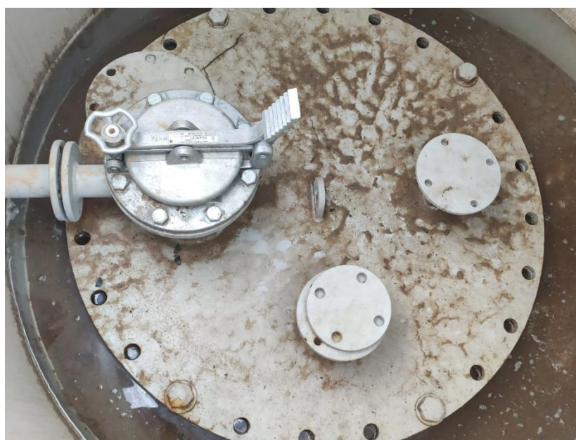
Рисунок 3 – Общий вид резервуара РГС-50 зав.№ 205
