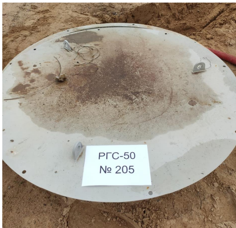
Рисунок 2 – Общий вид резервуара РГС-50 зав.№ 205
