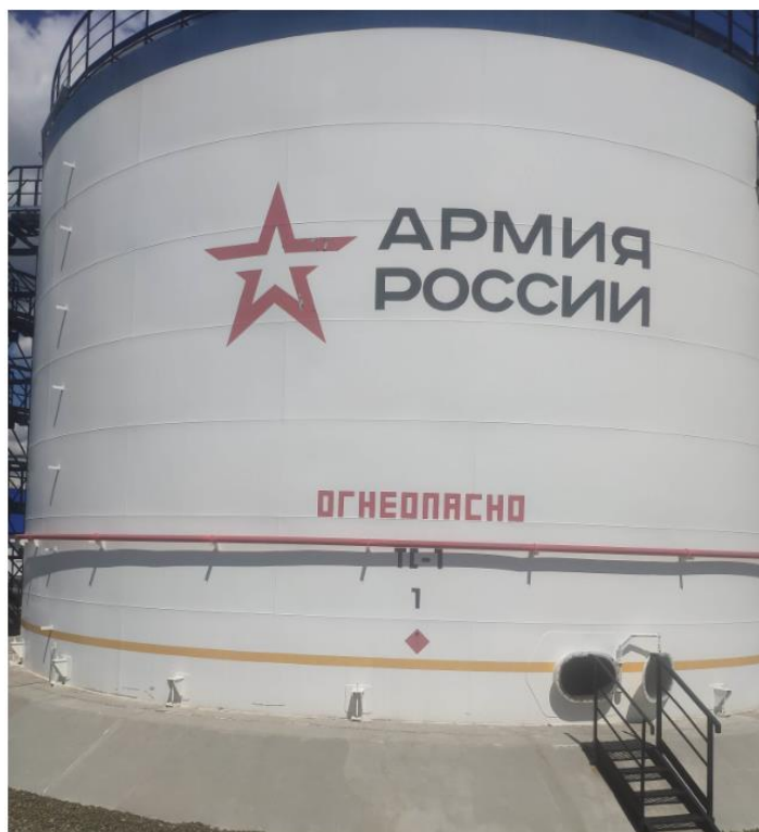
Рисунок 3 – Общий вид резервуара вертикального стального цилиндрического РВС-3000, зав. № 09-17
