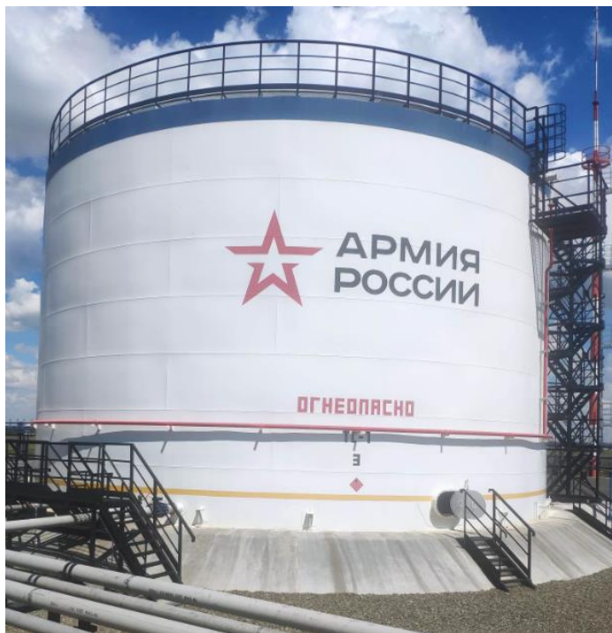
Рисунок 1 – Общий вид резервуара вертикального стального цилиндрического РВС-3000, зав. № 07-17
