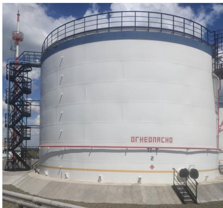
Рисунок 2 – Общий вид резервуара вертикального стального цилиндрического РВС-3000, зав. № 08-17
