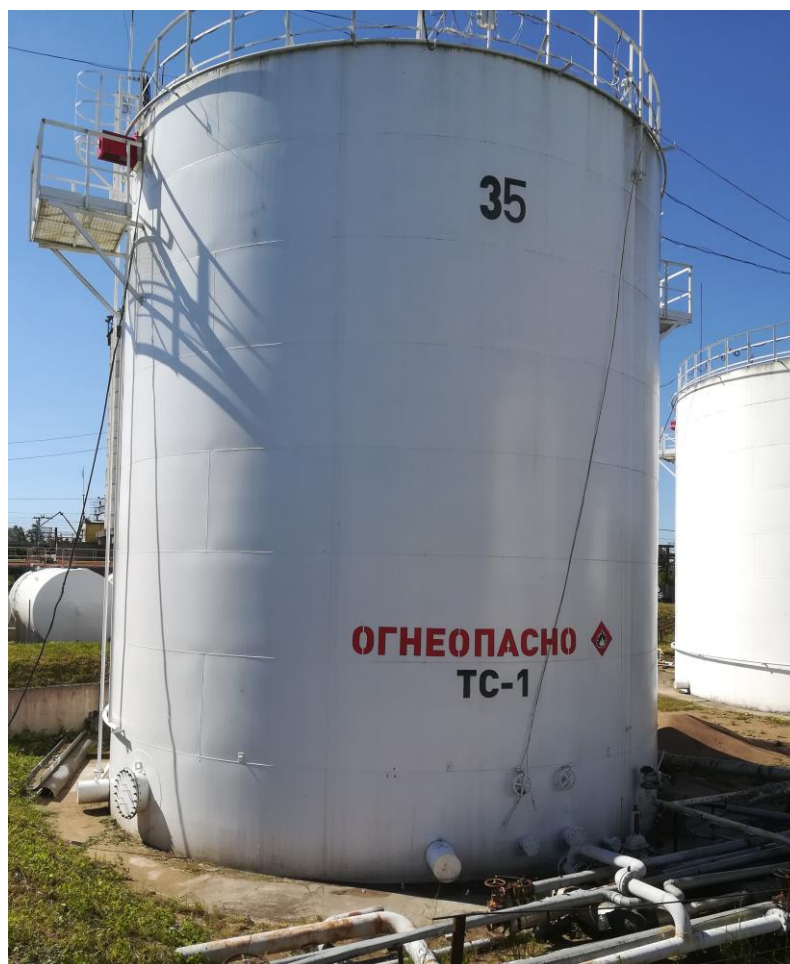
Рисунок 1 – Общий вид резервуара РВС-1000
