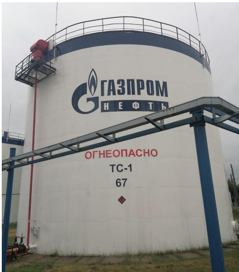
Рисунок 1 – Общий вид резервуара РВС-2000
