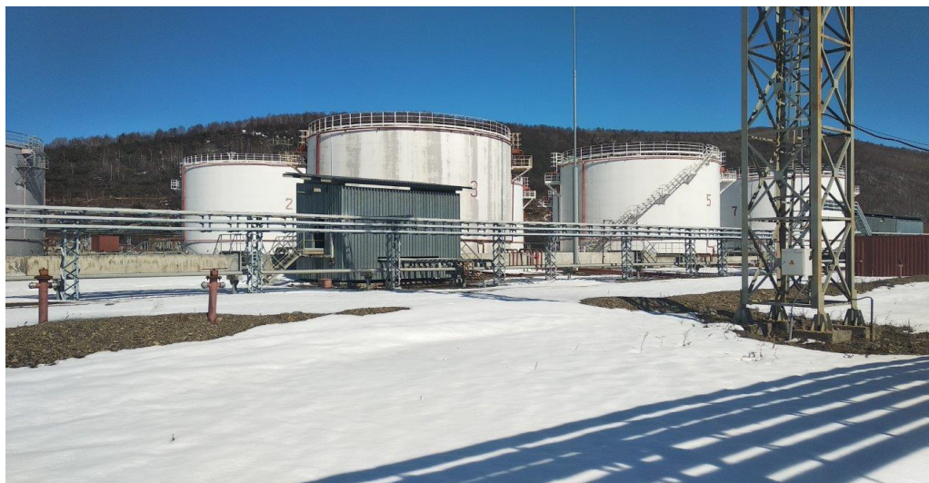
Рисунок 1 – Общий вид резервуаров стальных вертикальных цилиндрических РВС-3000
