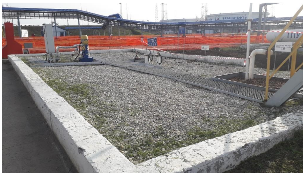
Рисунок 2 – Общий вид надземной части резервуара РГС-75 зав.№ ЕП-3
