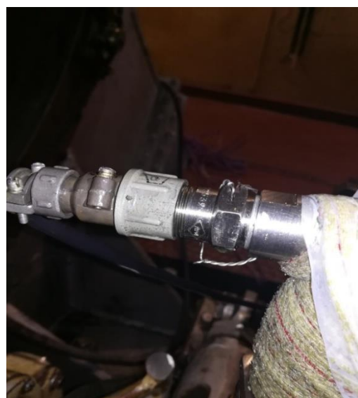
Рисунок 14 – Термосопротивление ТП-9201. Монтаж по месту
