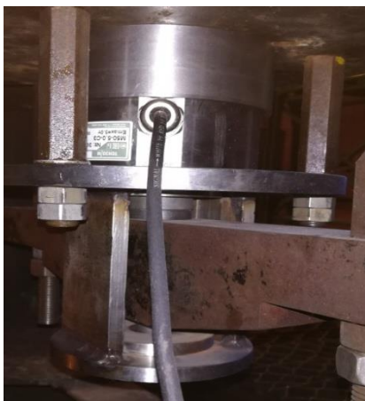
Рисунок 5 – Датчик весоизмерительный тензорезисторный М50-С3. Монтаж по месту
