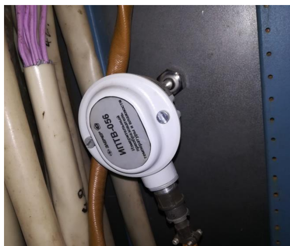
Рисунок 10 – Измерительный преобразователь температуры и влажности ИПТВ-056/М3-03. Монтаж по месту
