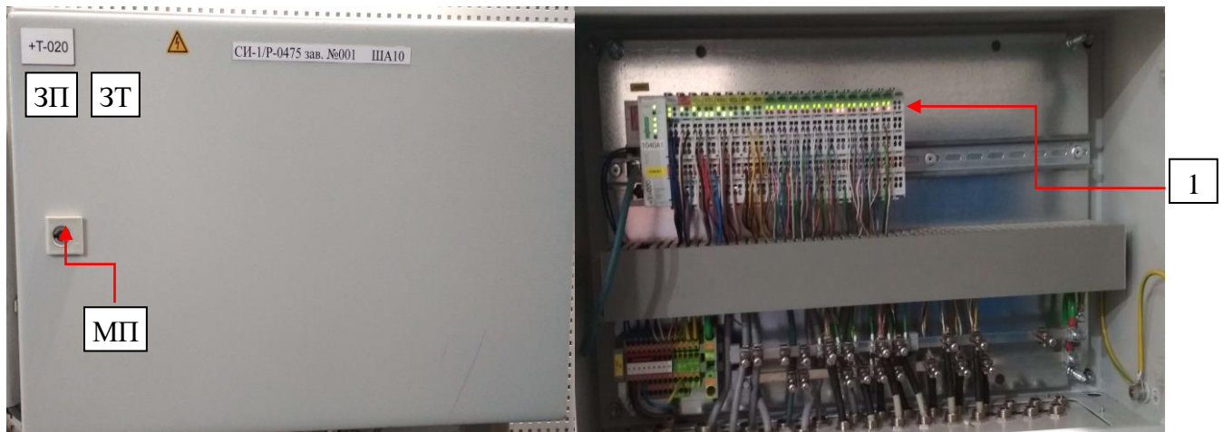
Рисунок 8 - Общий вид и внутреннее устройство шкафа ША10
