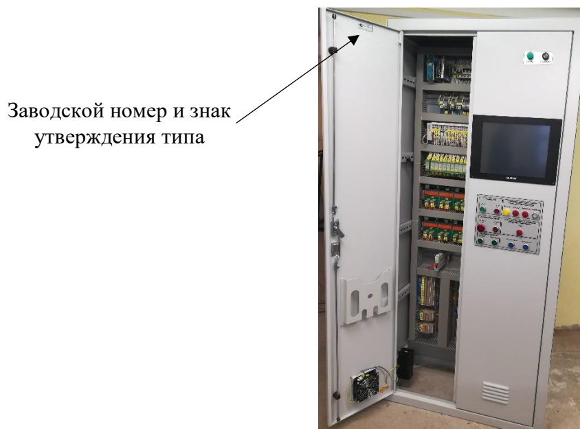
Рисунок 3 – Места расположения заводских номеров и знаков утверждения типа
