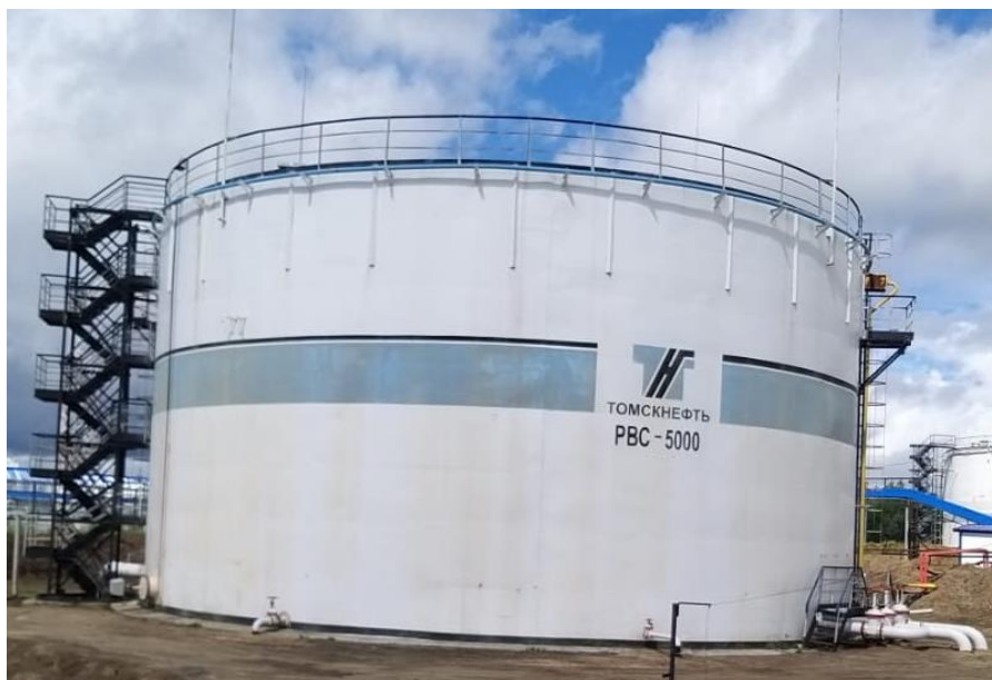
Рисунок 1 – Общий вид резервуара стального вертикального цилиндрического РВС-5000 (заводской номер: К-5-7012)
