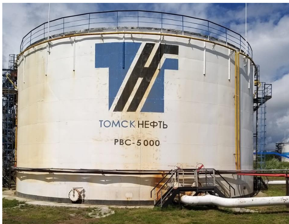
Рисунок 2 – Общий вид резервуара стального вертикального цилиндрического PBC-5000 (заводской номер: К-5-7016)
