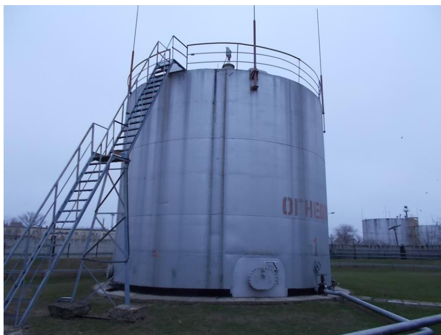
Рисунок 1 – Общий вид резервуаров стальных вертикальных цилиндрических РВС-700
