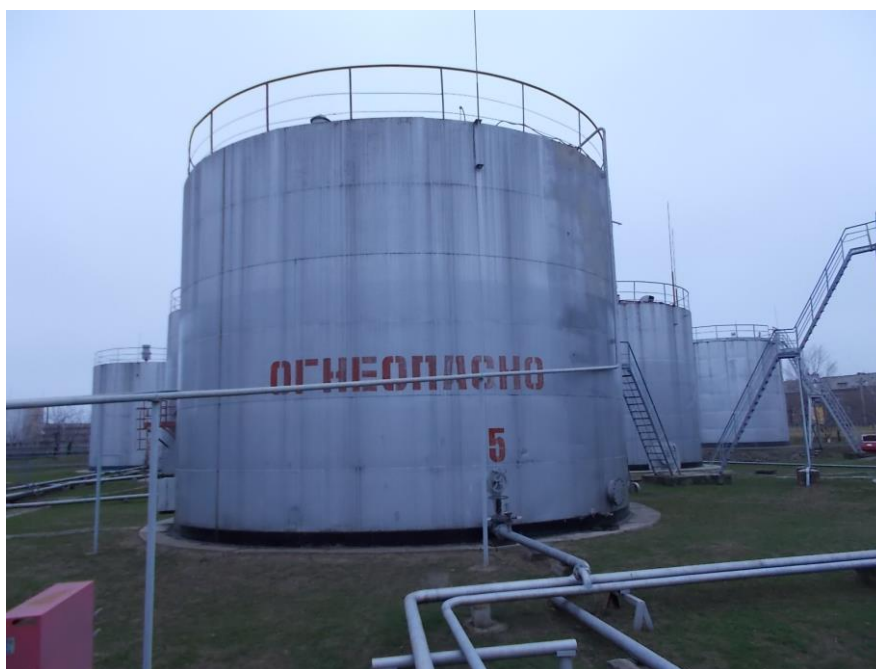
Рисунок 2 – Общий вид резервуаров стальных вертикальных цилиндрических РВС-1000
