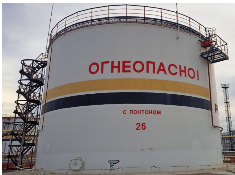
Рисунок 3 – Общий вид резервуаров стальных вертикальных цилиндрических РВСП-3000
