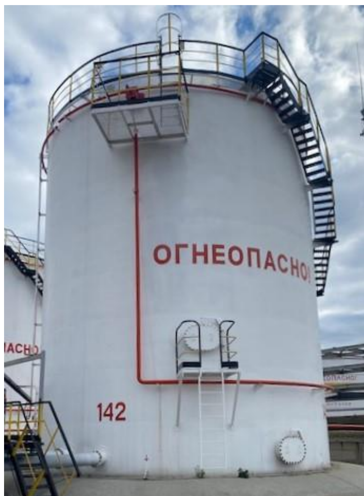
Рисунок 1 – Общий вид резервуара стального вертикального цилиндрического РВСП-1000
