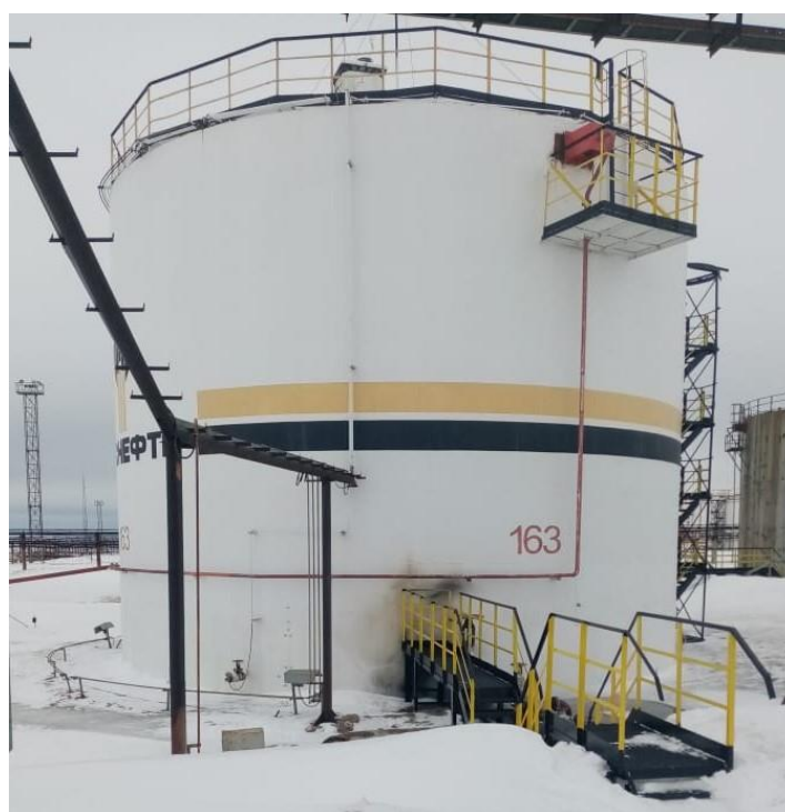
Рисунок 2 – Общий вид резервуара стального вертикального цилиндрического РВС-2000
