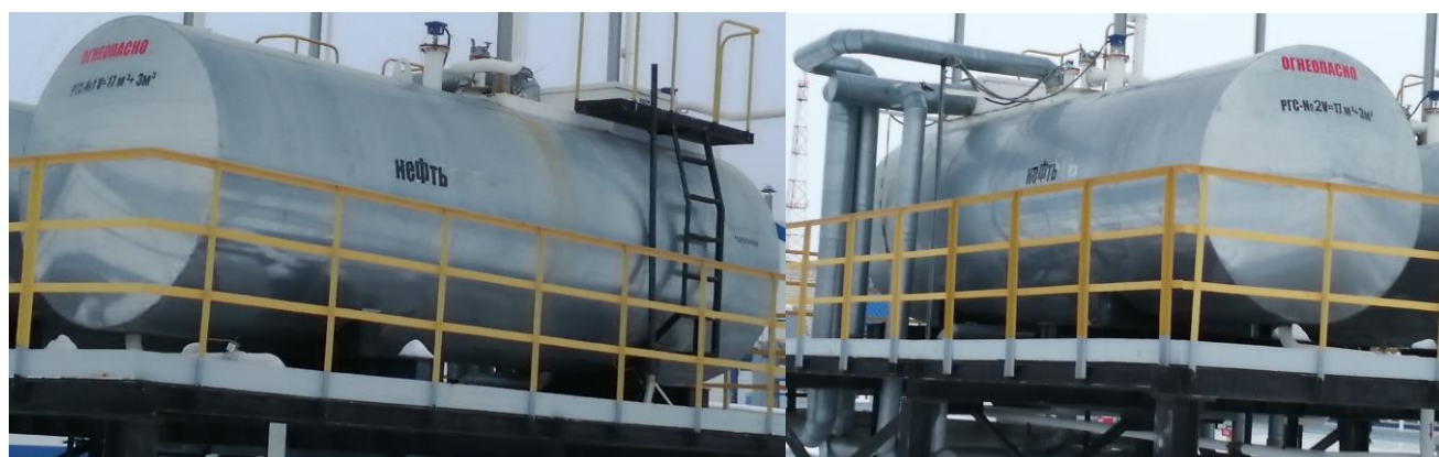
Рисунок 5 – Общий вид резервуаров РГС-20 зав. №№ 164, 165
