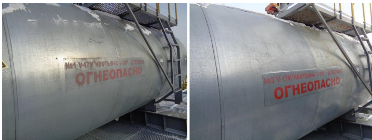
Рисунок 4 – Общий вид резервуаров РГС-20 зав. №№ 105, 106
