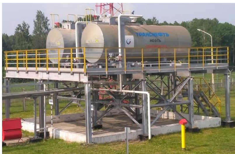
Рисунок 2 – Общий вид резервуаров РГС-20 зав. №№ 58, 111
