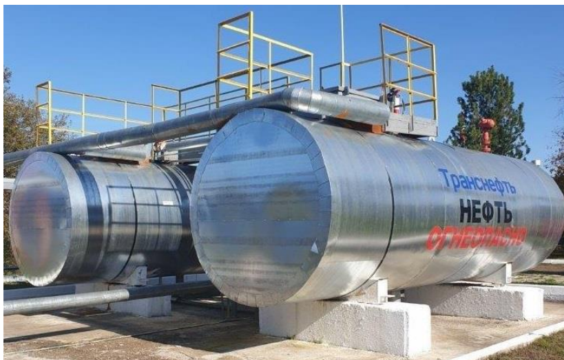
Рисунок 1 – Общий вид резервуаров РГС-20 зав. №№ 6, 9
