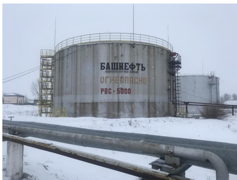
Рисунок 2 – Общий вид резервуаров стальных вертикальных цилиндрических РВС-5000
