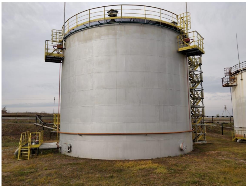
Рисунок 1 – Общий вид резервуаров стальных вертикальных цилиндрических РВС-2000
