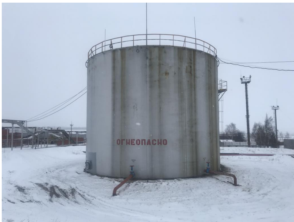
Рисунок 3 – Общий вид резервуаров стальных вертикальных цилиндрических РВС-2000
