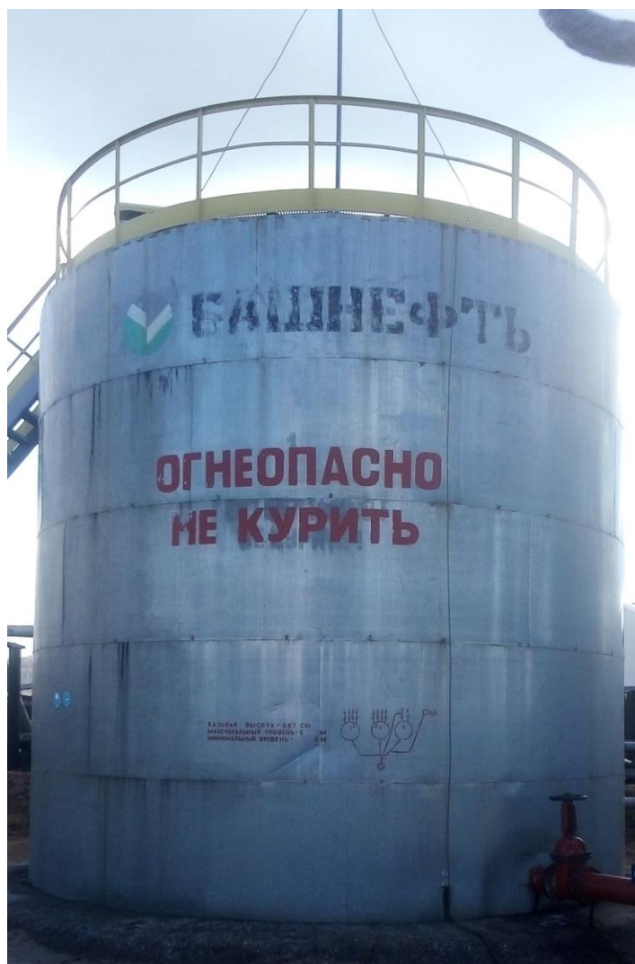
Рисунок 1 – Общий вид резервуаров стальных вертикальных цилиндрических РВС-200
