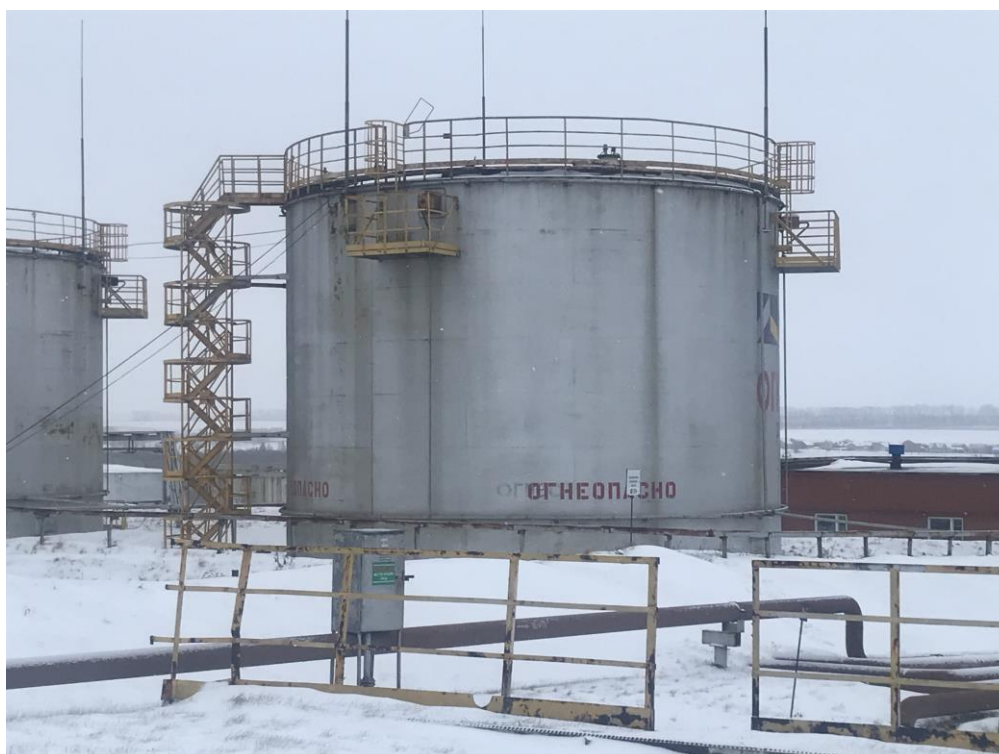
Рисунок 4 – Общий вид резервуаров стальных вертикальных цилиндрических РВС-5000
