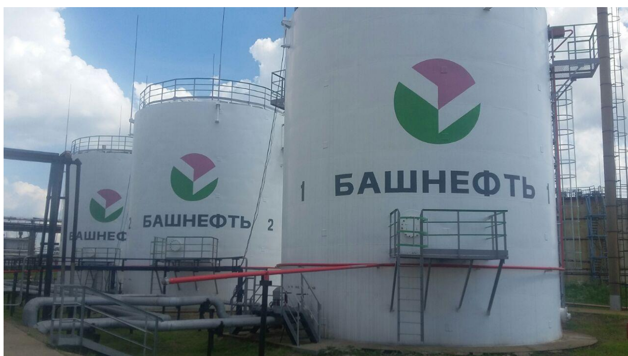
Рисунок 2 – Общий вид резервуаров стальных вертикальных цилиндрических РВС-1000
