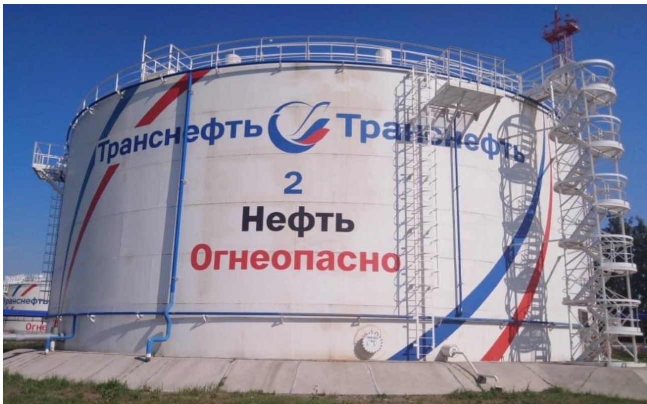
Рисунок 1 – Общий вид резервуара РВСП-10000
