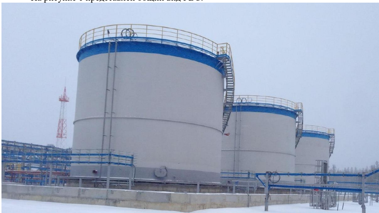
Рисунок 1 – Общий вид резервуаров стальных вертикальных цилиндрических РВС-2000, заводские номера 1, 2, 3
