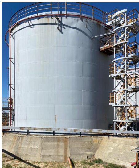
Рисунок 1 – Общий вид резервуара РВСП-2000 зав. №№ Е-302, Е-303
