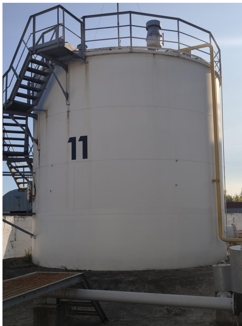
Рисунок 1 – Общий вид резервуара РВСП-200
