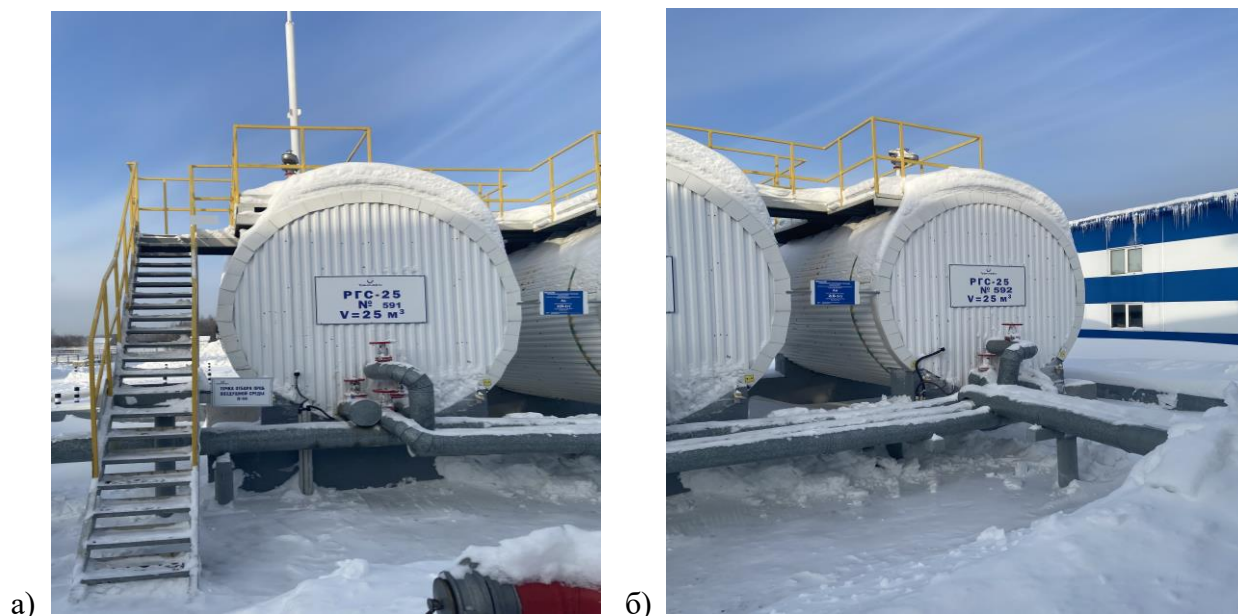
Рисунок 1 – Общий вид резервуара РГС-25 а) зав. № 591, б) зав. № 592
