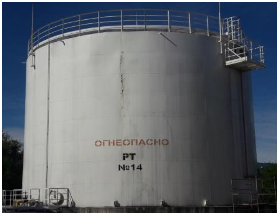
Рисунок 1 – Общий вид резервуара стального вертикального цилиндрического РВС-3000
