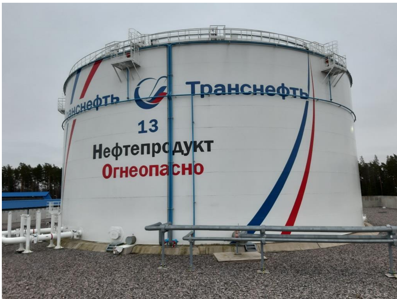
Рисунок 1 – Общий вид резервуара РВСП-20000
