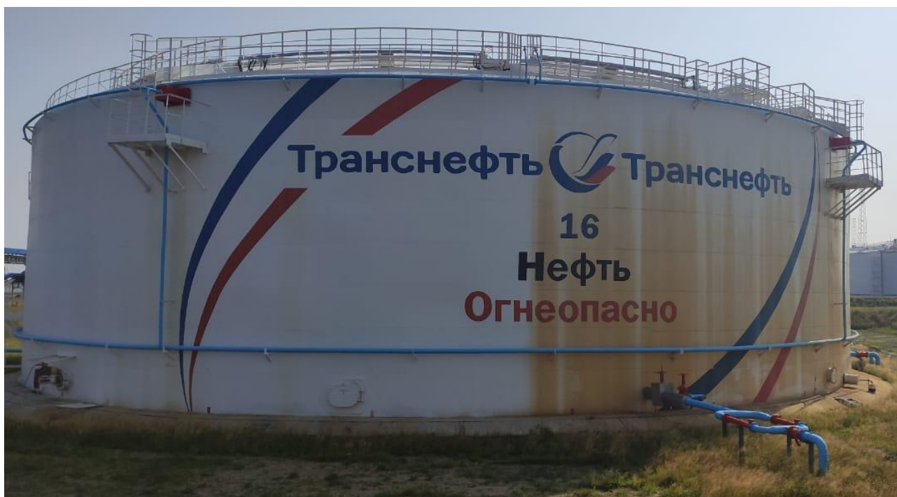
Рисунок 1 – Общий вид резервуара РВСП-20000
