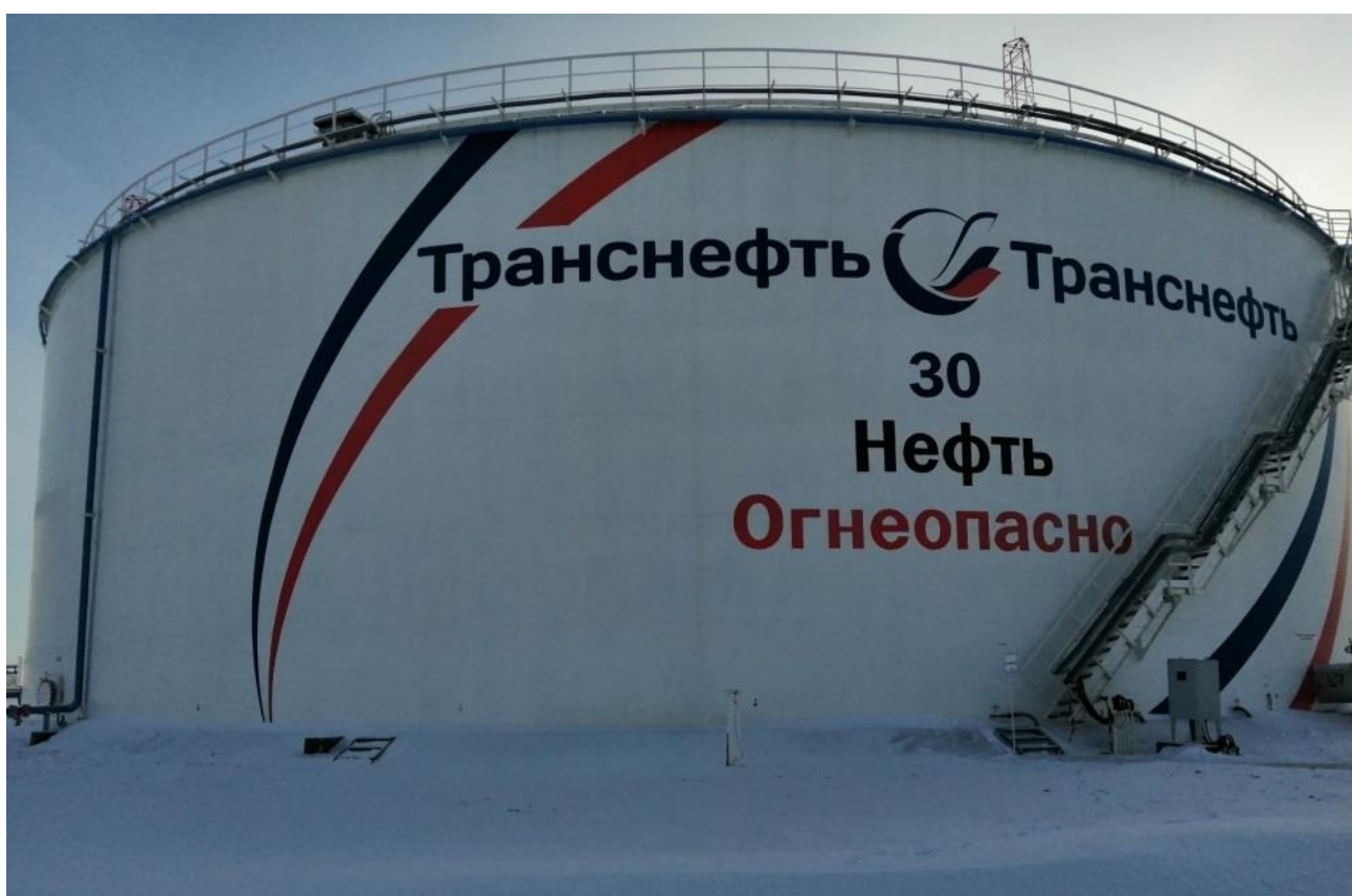
Рисунок 2 – Общий вид резервуара РВС-20000
