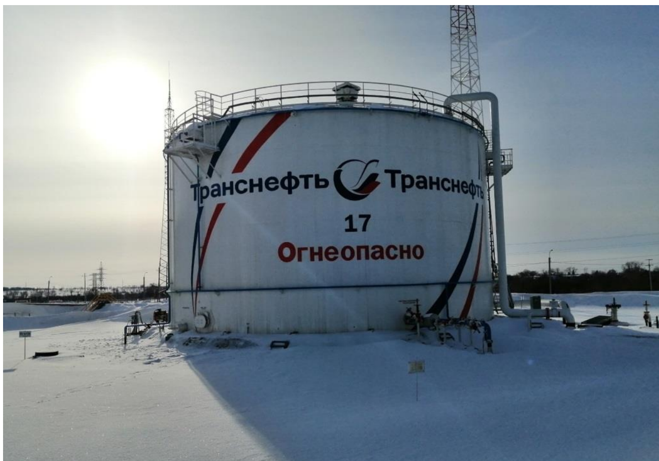
Рисунок 1 – Общий вид резервуара РВС-5000
