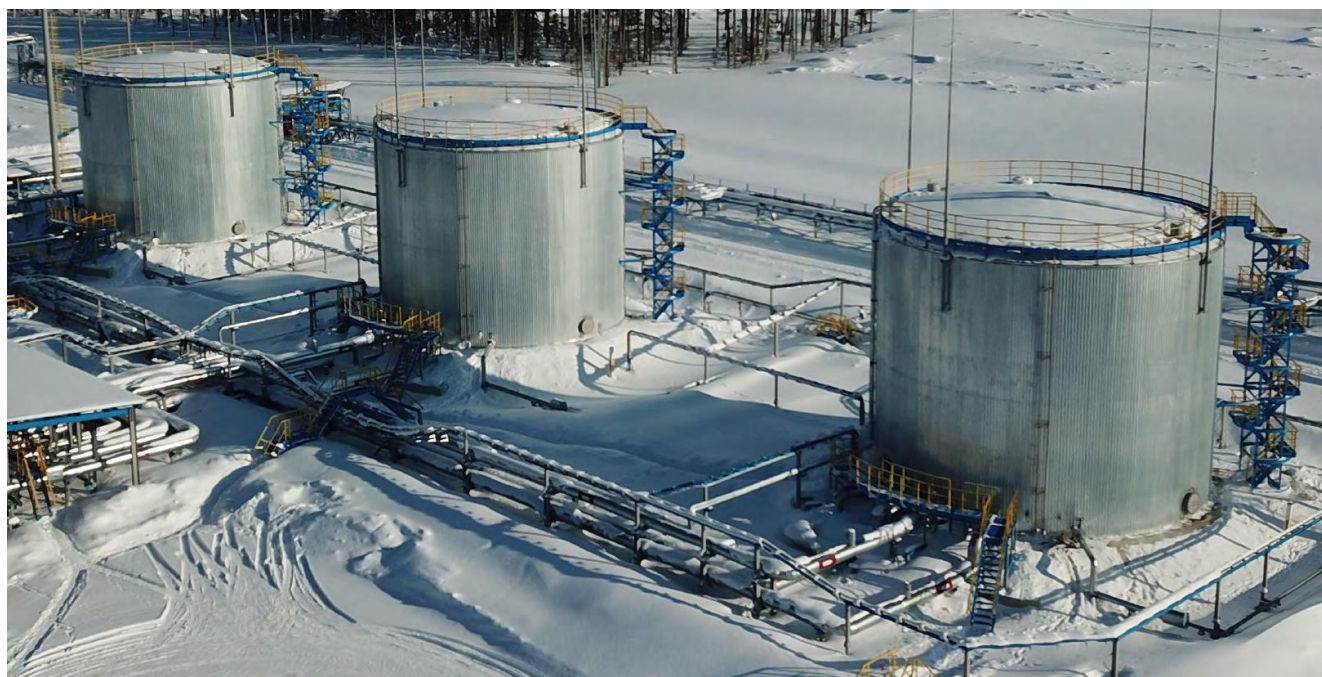
Рисунок 1 – Общий вид резервуаров стальных вертикальных цилиндрических РВС-2000, заводские номера 1, 2, 3
