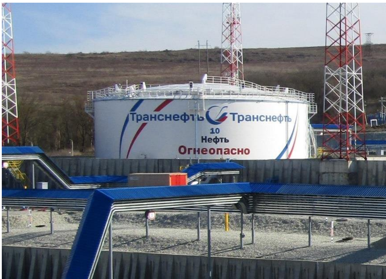
Рисунок 1 – Общий вид резервуаров РВСП-10000
