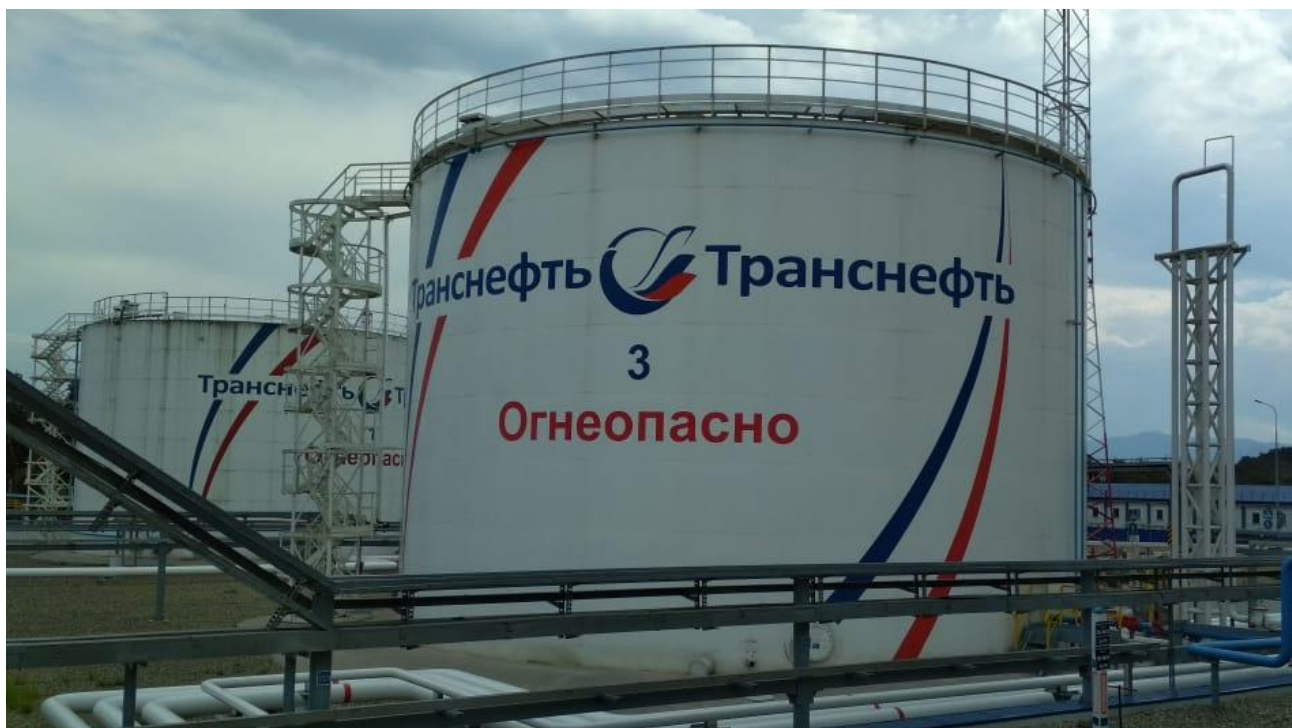
Рисунок 1 – Общий вид резервуаров РВС-3000
