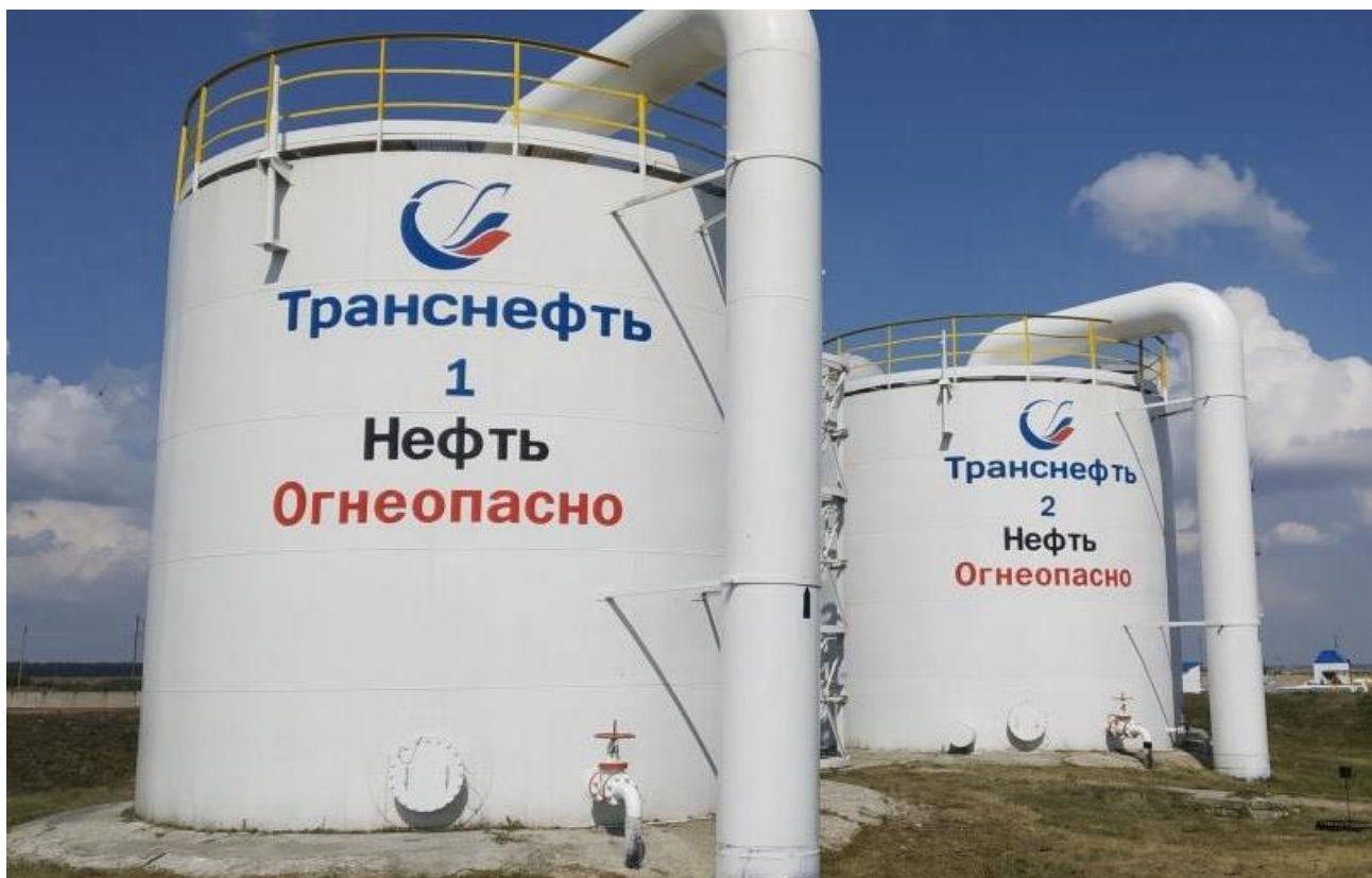
Рисунок 1 – Общий вид резервуаров РВС-400
