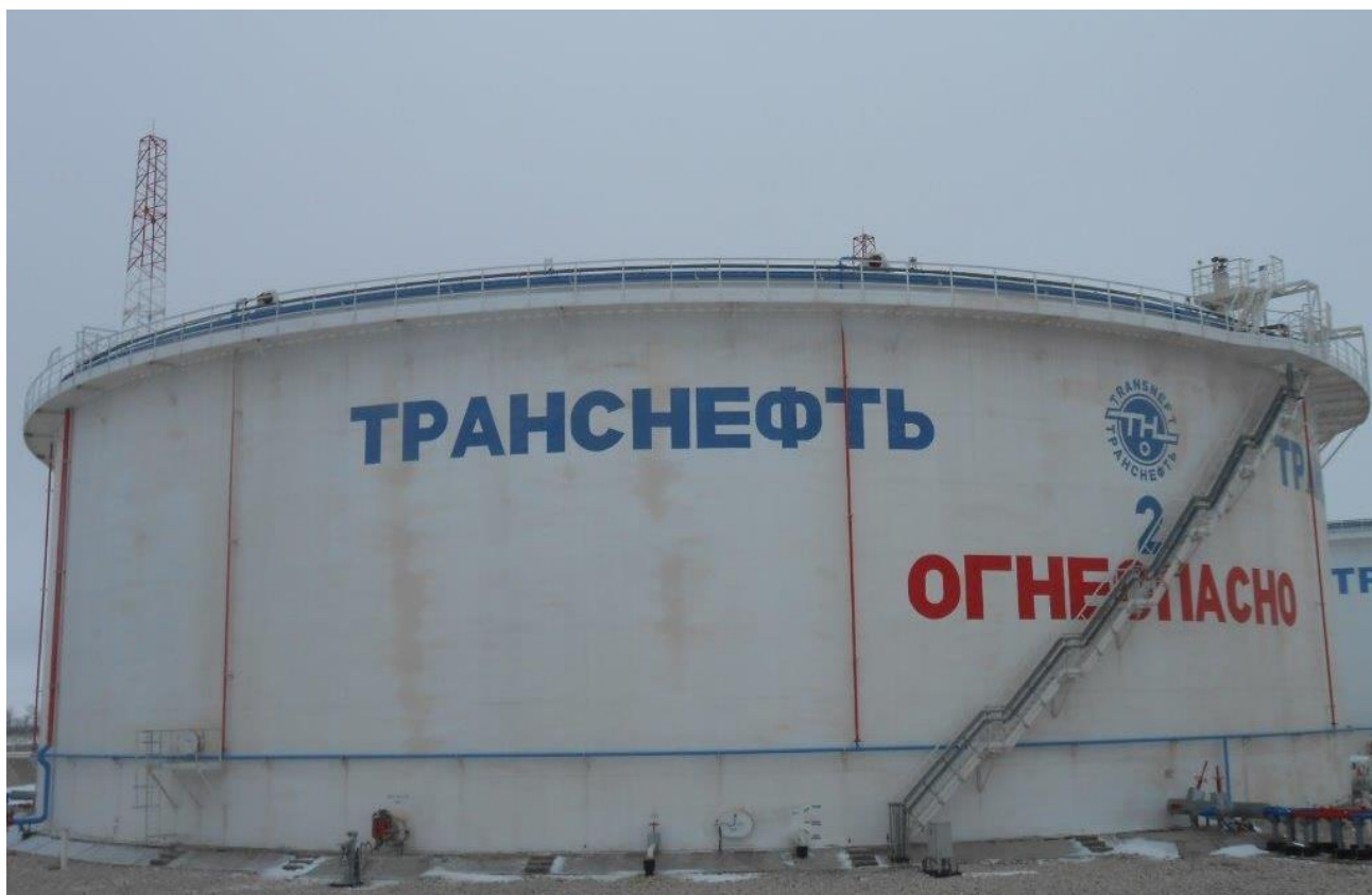
Рисунок 1 – Общий вид резервуара РВСПК-50000
