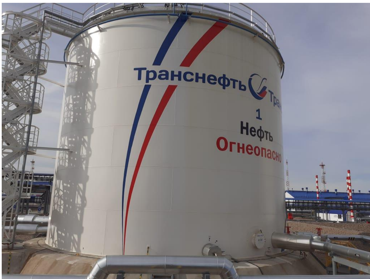
Рисунок 1 – Общий вид резервуаров РВС-2000
