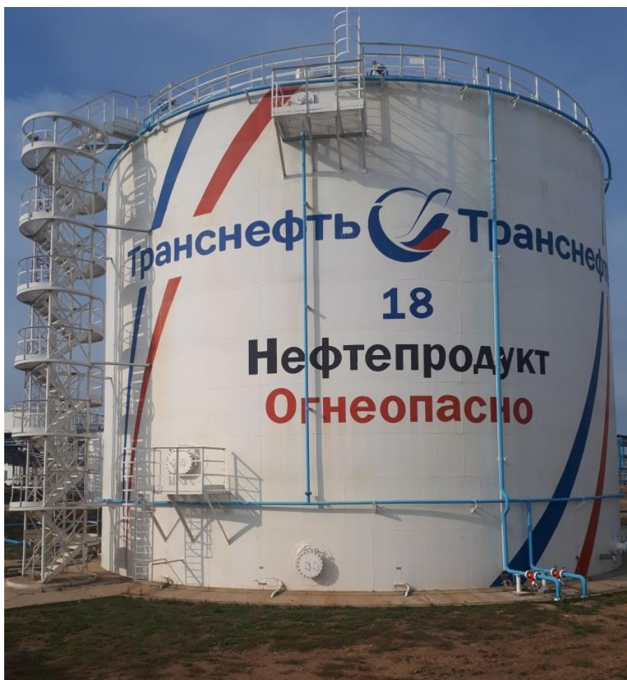
Рисунок 1 – Общий вид резервуаров РВСП-5000
