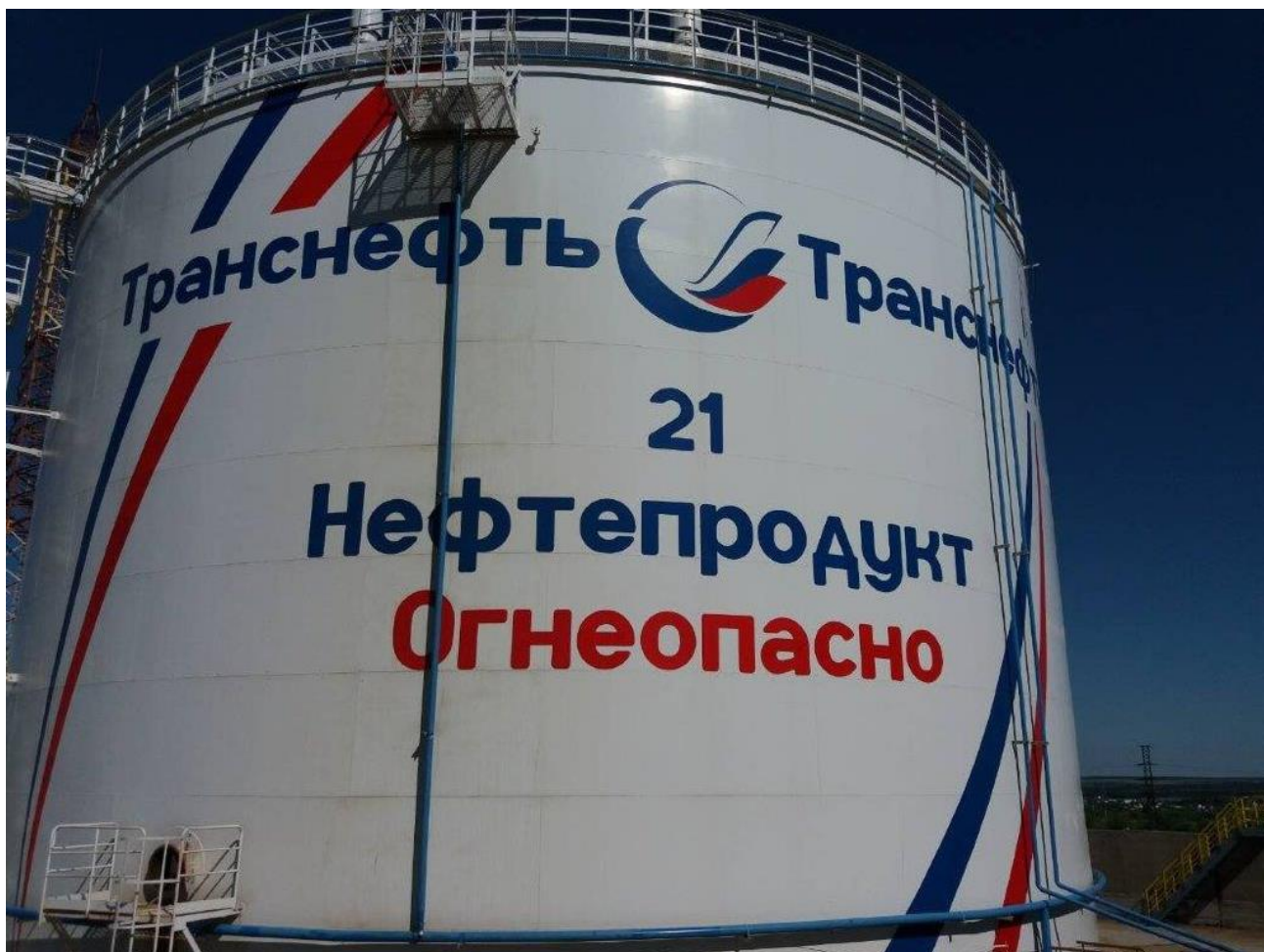
Рисунок 1 – Общий вид резервуара РВСП-10000
