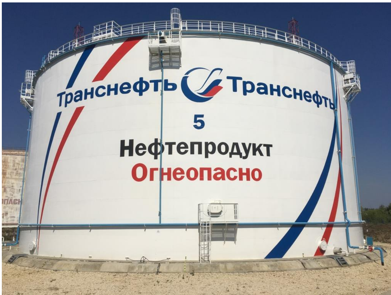
Рисунок 1 – Общий вид резервуара РВСП-20000
