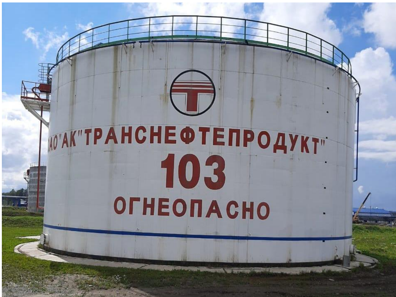
Рисунок 1 – Общий вид резервуаров РВС-5000
