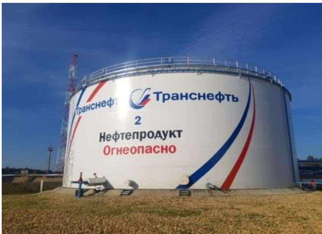
Рисунок 1 – Общий вид резервуара РВС-10000
