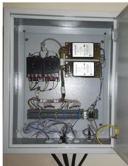
Рисунок 9 – Шкаф ПП напряжения постоянного тока ШкДПТ. Вид внутри
