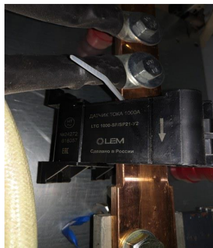
Рисунок 9 – Шкаф ПП напряжения постоянного тока ШкДПТ. Вид внутри
