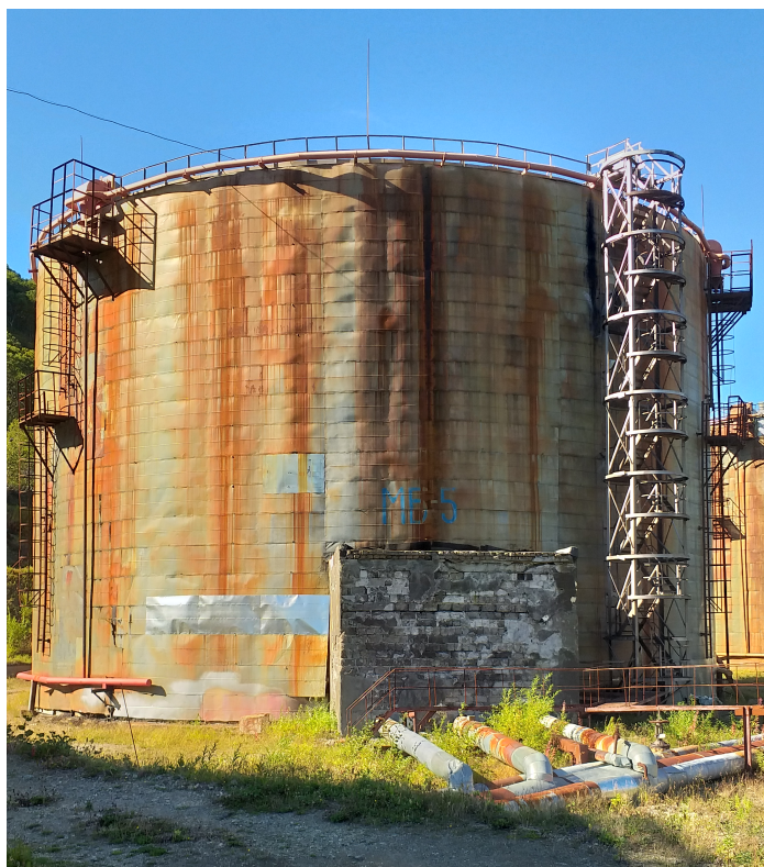
Рисунок 1 – Общий вид резервуара РВС-10000 Пломбирование резервуара стального вертикального цилиндрического теплоизолированного РВС-10000 не предусмотрено.
