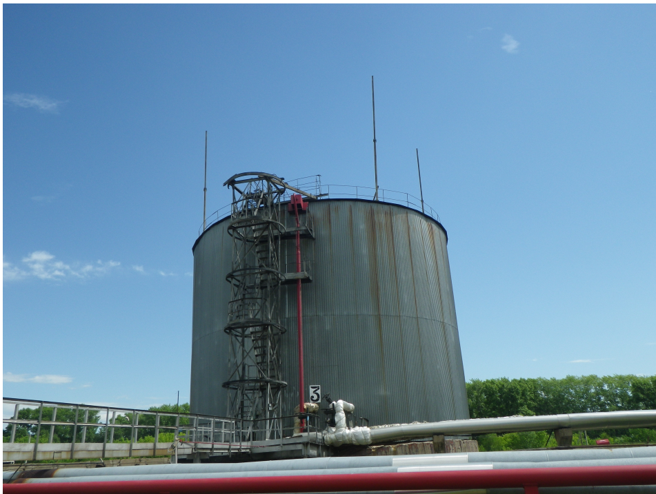
Рисунок 1 - Общий вид резервуара стального вертикального цилиндрического РВС-2000 зав.№ 3
