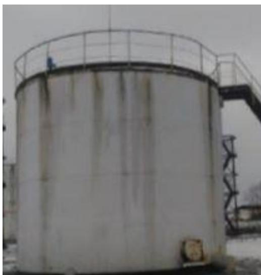
Рисунок 1 – Общий вид резервуара стального вертикального цилиндрического РВСП-200
