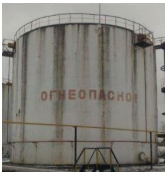
Рисунок 5 – Общий вид резервуара стального вертикального цилиндрического РВС-2000
