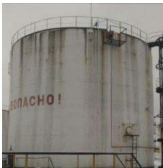
Рисунок 6 – Общий вид резервуара стального вертикального цилиндрического РВСП-2000
