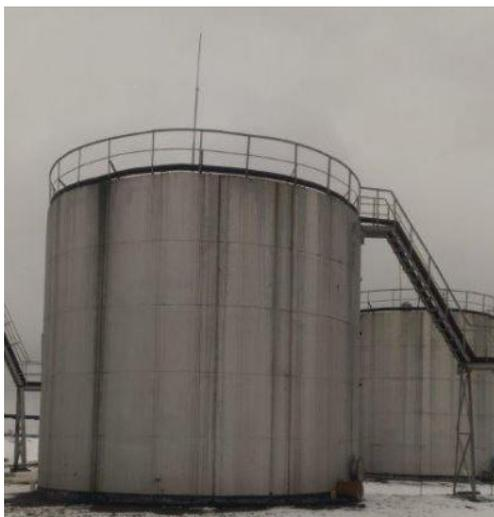
Рисунок 2 – Общий вид резервуаров стальных вертикальных цилиндрических РВС-400
