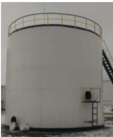
Рисунок 3 – Общий вид резервуара стального вертикального цилиндрического РВСП-400
