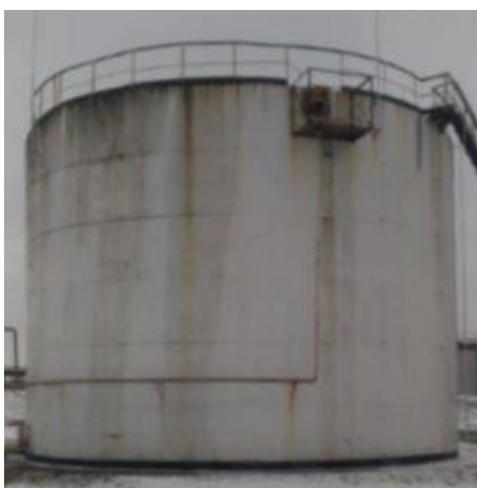
Рисунок 4 – Общий вид резервуара стального вертикального цилиндрического РВС-1000
