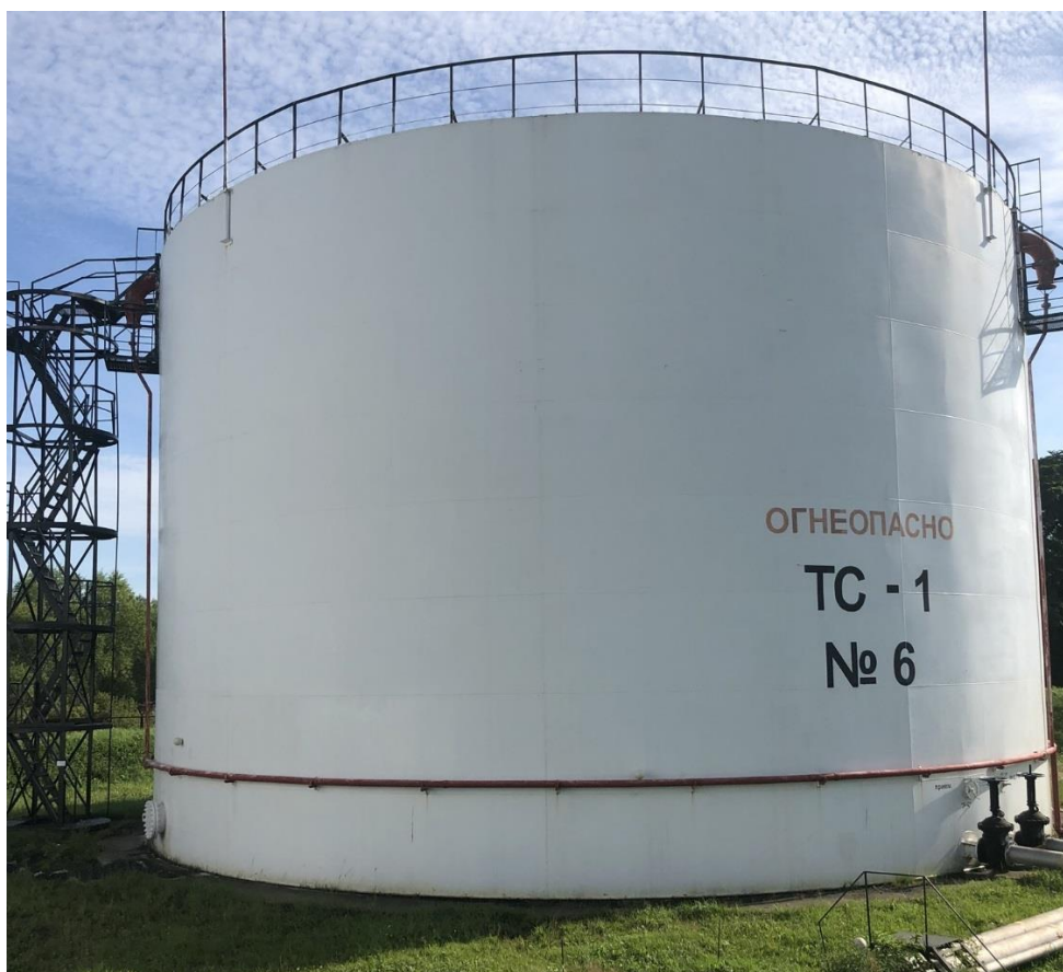
Рисунок 1 – Общий вид резервуара РВС-3000 зав.№ 6
