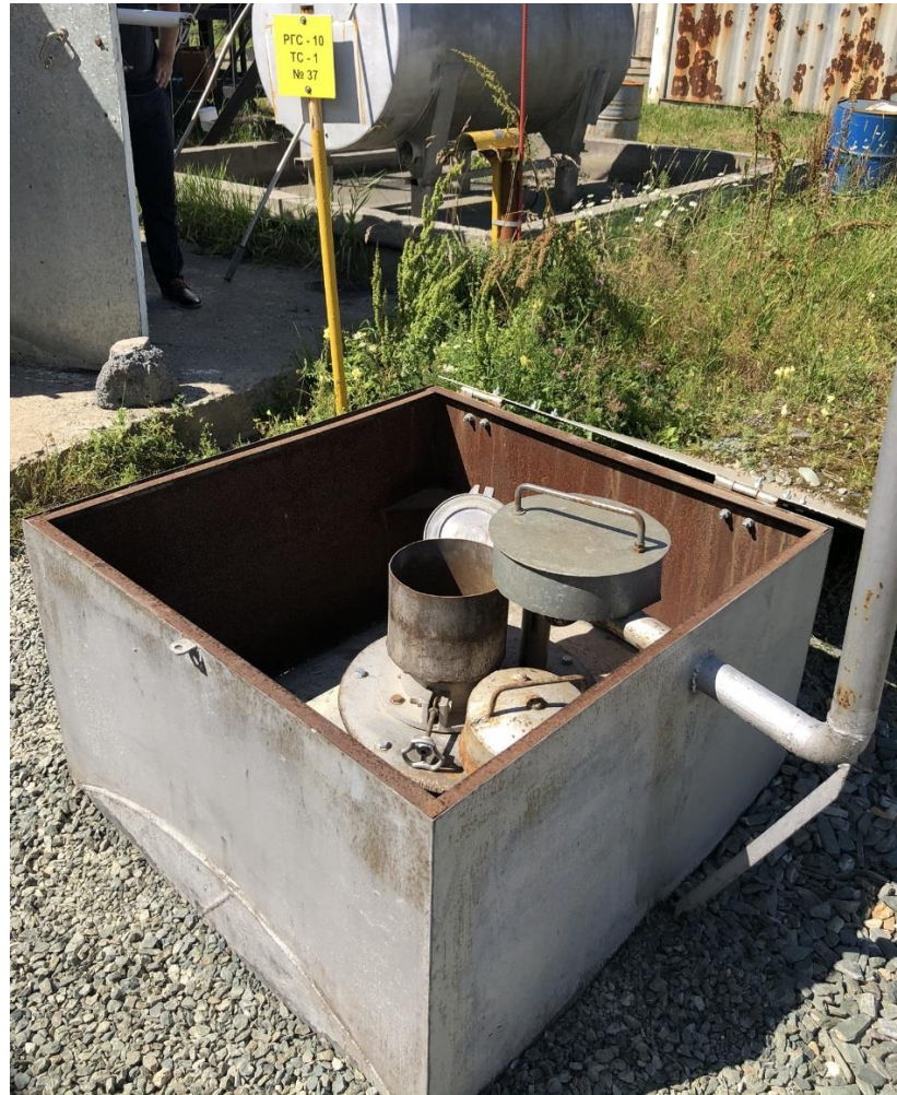
Рисунок 4 – Общий вид резервуара РГС-10 зав.№ 37
