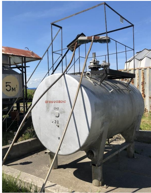
Рисунок 1 – Общий вид резервуара РГС-3 зав.№ 20
