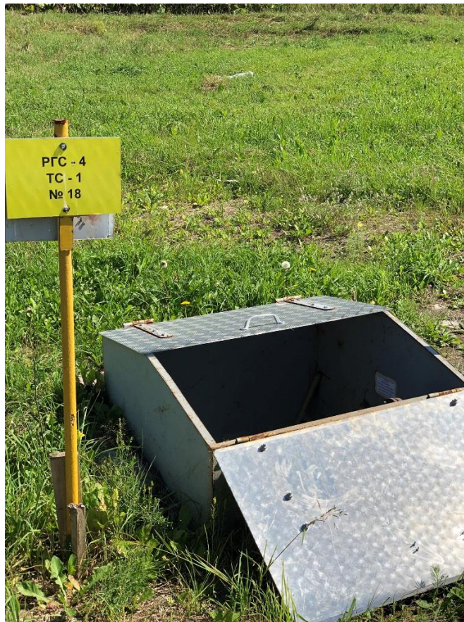
Рисунок 2 – Общий вид резервуара РГС-4 зав.№ 18
