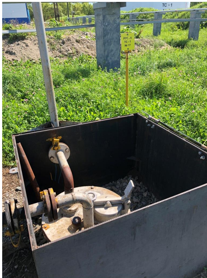
Рисунок 3 – Общий вид резервуара РГС-5 зав.№ 17
