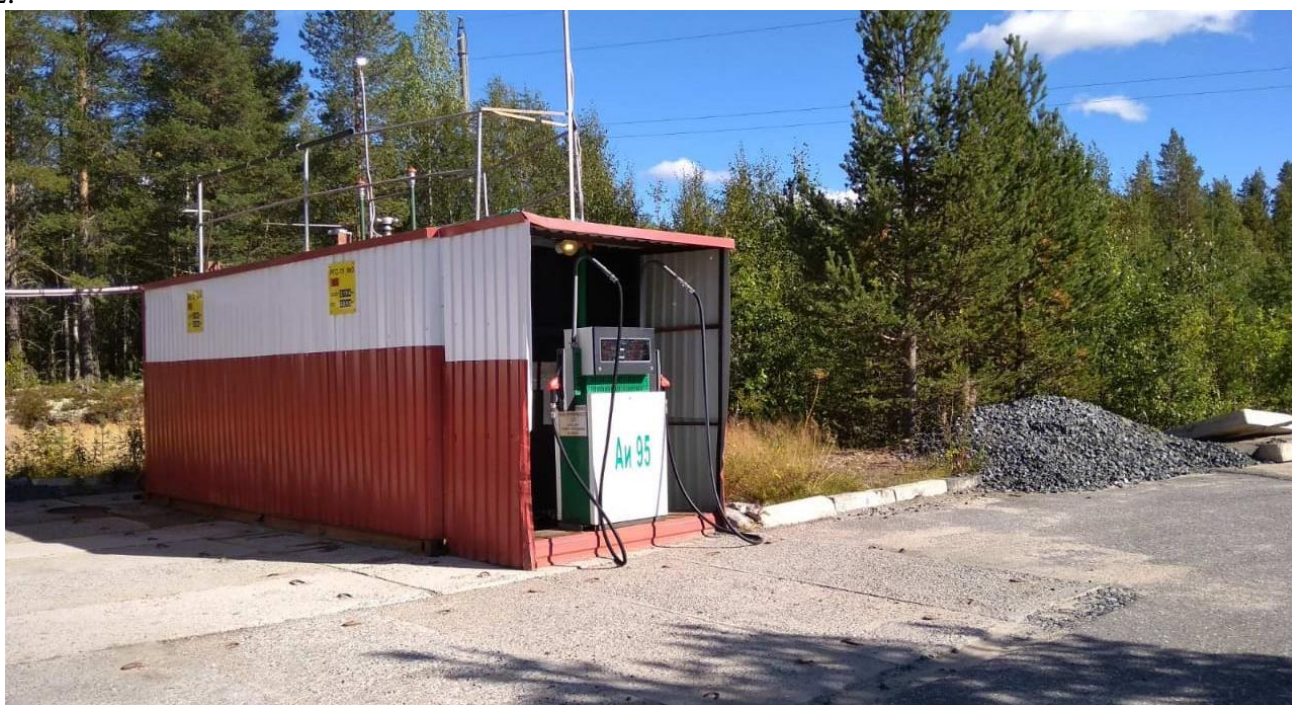
Рисунок 1 – Общий вид резервуара РГС-30
