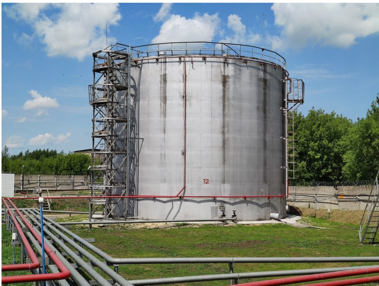
Рисунок 1 – Общий вид резервуара вертикального стального цилиндрического РВС-2000
