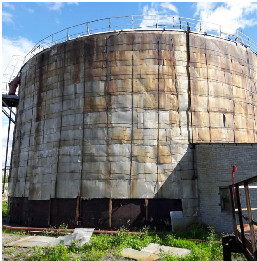
Рисунок 1 – Общий вид резервуара РВС-5000
