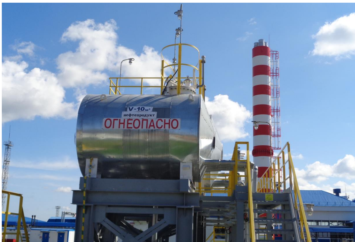
Рисунок 1 – Общий вид резервуара РГС-10
