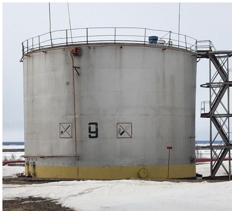
Рисунок 2 – Общий вид резервуара стального вертикального цилиндрического РВС-1000
