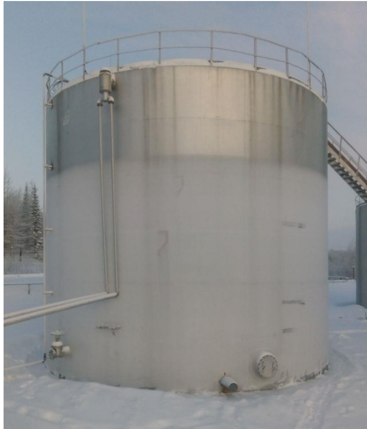
Рисунок 1 – Общий вид резервуаров стальных вертикальных цилиндрических РВС-700
