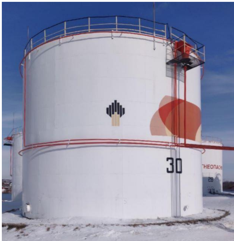
Рисунок 3 – Общий вид резервуаров стальных вертикальных цилиндрических РВС-2000
