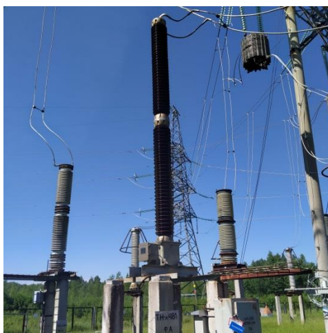
Рисунок 1 – Общий вид трансформаторов напряжения СЗVT 362/8
